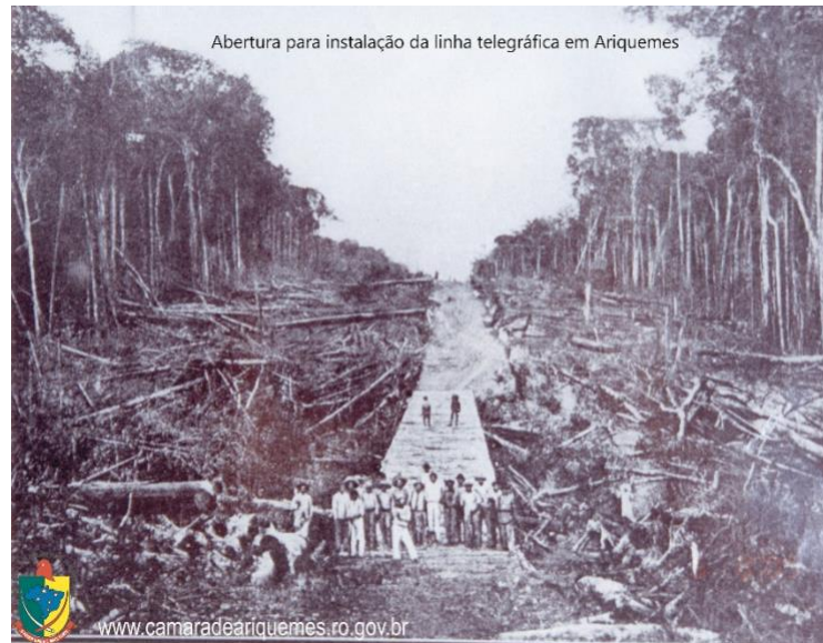
Figura 3 – Abertura para instalação da linha telegráfica em Ariquemes
